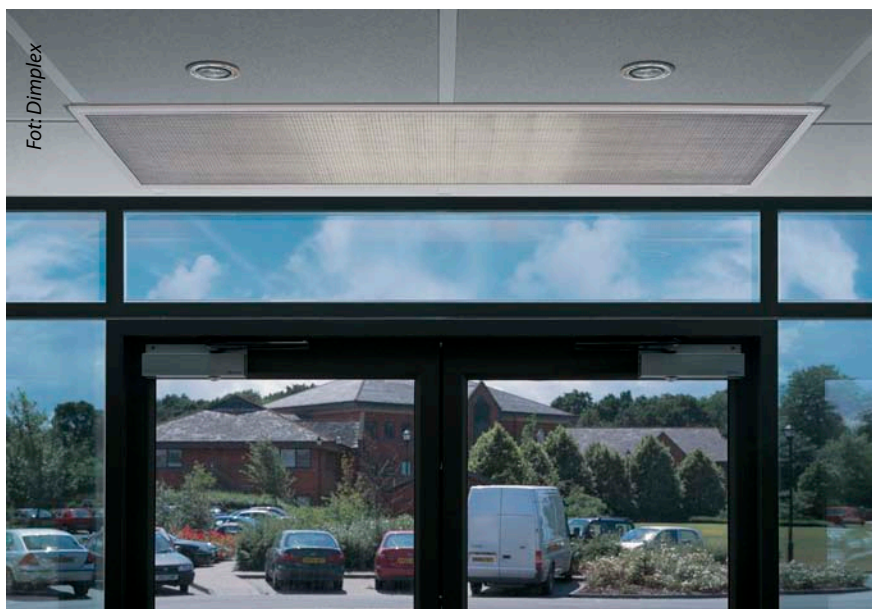
FOT. 7. Kurtyna powietrzna montowana w zabudowie w suficie podwieszonym o tylko jednej widocznej kratce wylotowej.
