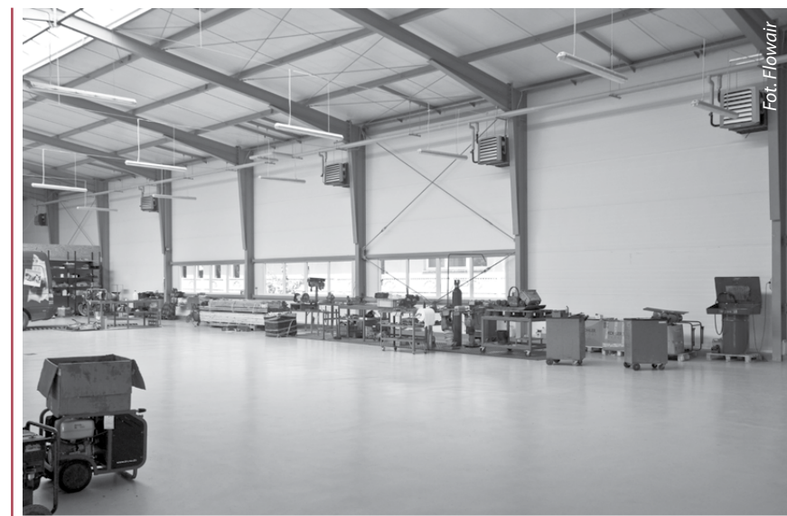
Fot. 6. Przy montażu nagrzewnic trzeba przestrzegać podstawowych zasad związanych z dystrybucją powietrza. Nagrzewnice należy montować tak aby zapewnić równomierne rozprowadzenie powietrza w całej objętości pomieszczenia.
